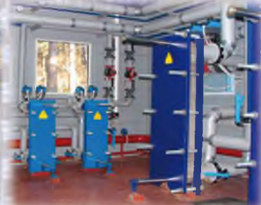
Монтаж і пусконаладження
